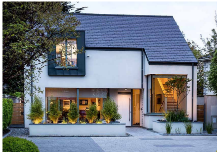
Pasivna kuća Wayside Cork, Irska
